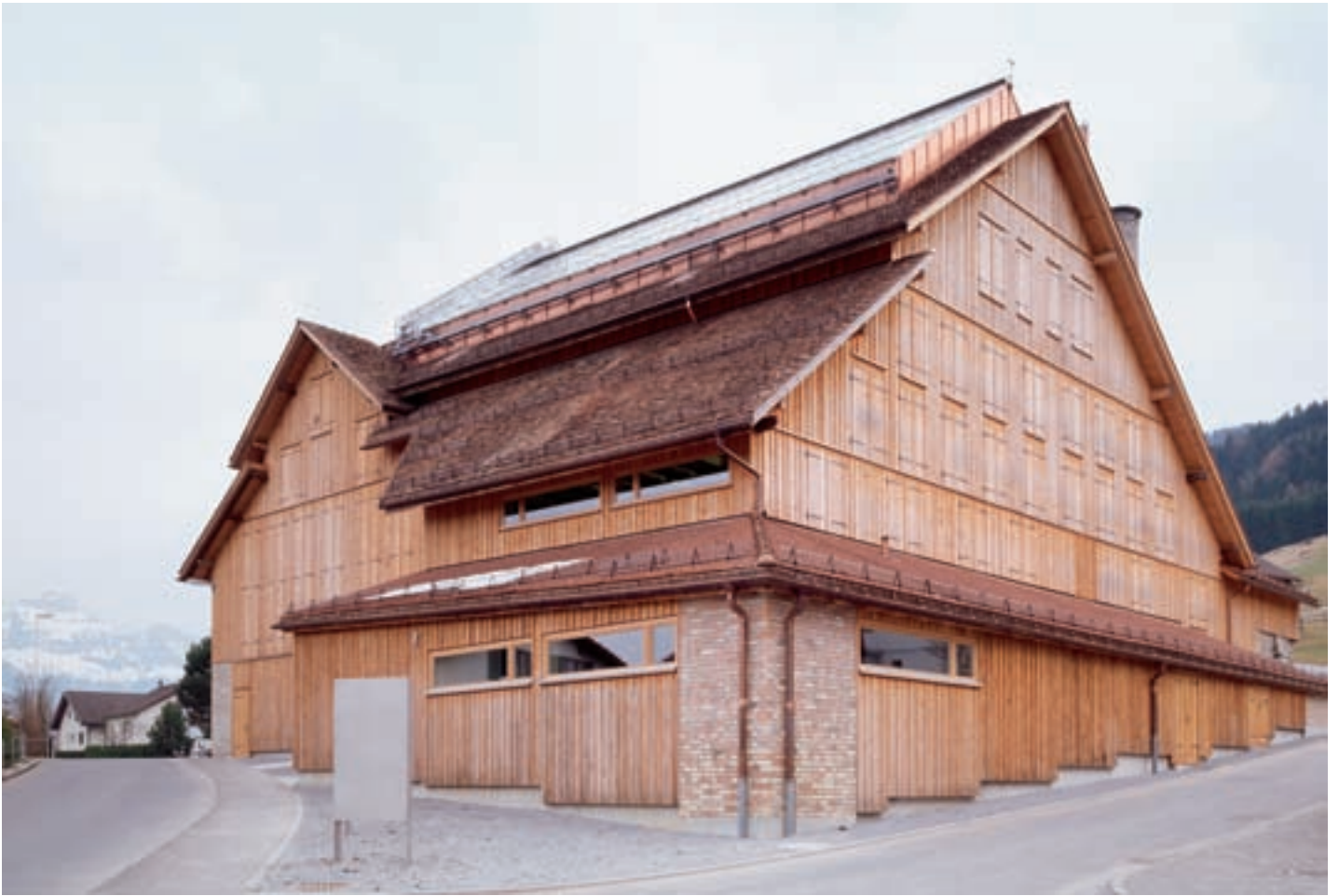
Ziegelhütte von Nordwesten mit Dachoberlicht über der Kunsthalle
