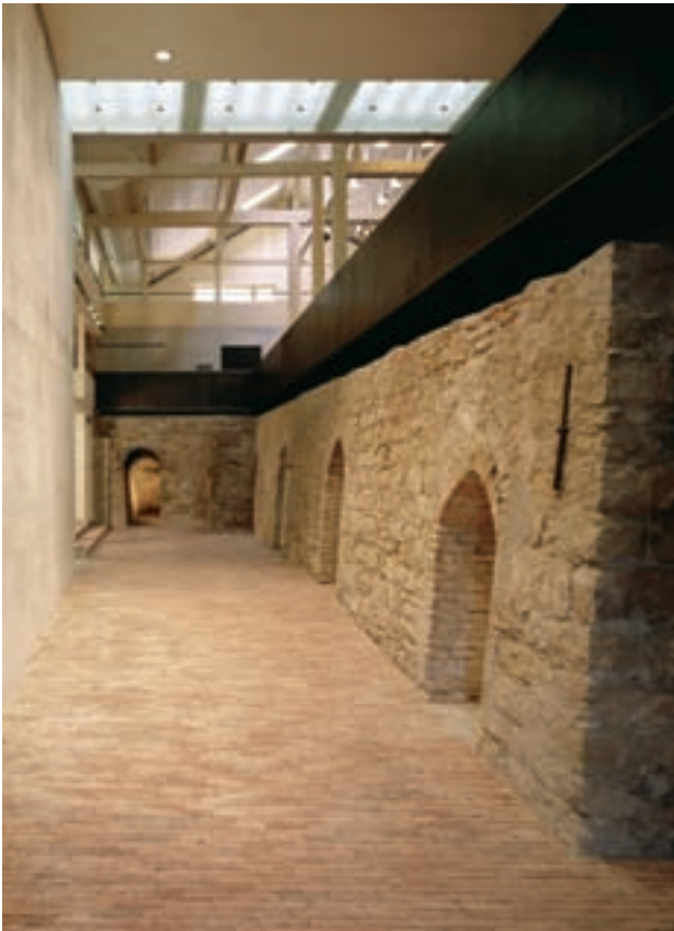
Ziegel-Brennofen von 1566 mit Stahldeck für Mehrzwecknutzung
